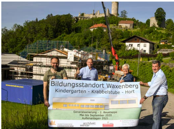
V.l.: Schulwart Josef Hochreither, Bgm. DI Josef Rathgeb, Vzbgm. Anneliese Bräuer und GV Josef Keplinger beim Lokalaugenschein der Sanierungsarbeiten am Bildungsstandort Waxenberg.
