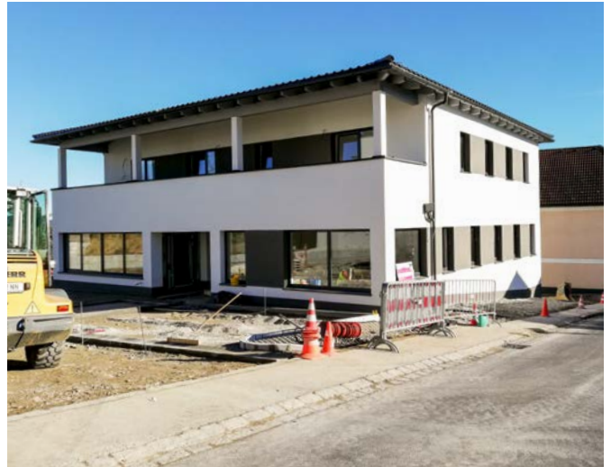
Das Ziel der Ortskernbelebung verfolgt auch das Raiffeisen-Haus in Traberg. Dieses Haus mit digitaler Bankstelle, Gesellschaftsfläche und drei Wohnungen wird Anfang 2021 eröffnet.
