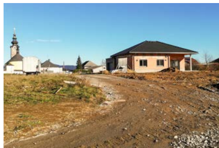
Auch in Traberg entstanden am alten Sportplatz mitten im Ort 10 Bauparzellen. Im Winter wird der erste Hausbesitzer sein neues Heim beziehen. Ein weiteres Bauvorhaben steht schon in den Startlöchern.
