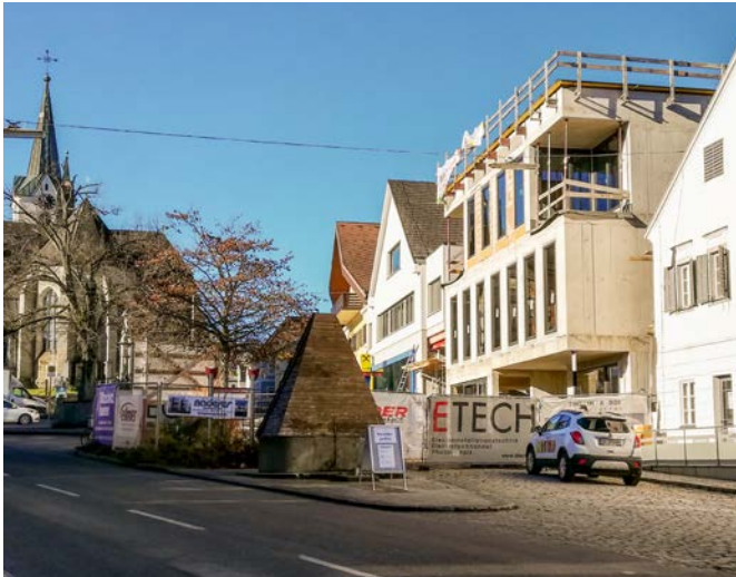
Der Neubau des Kommunalen Dienstleistungszentrums mitten am Ortsplatz in Oberneukirchen wird in Zukunft für mehr Leben im Ort sorgen. Die Bauarbeiten liegen im Zeitplan. Die Eröffnung ist für Herbst 2021 geplant.
